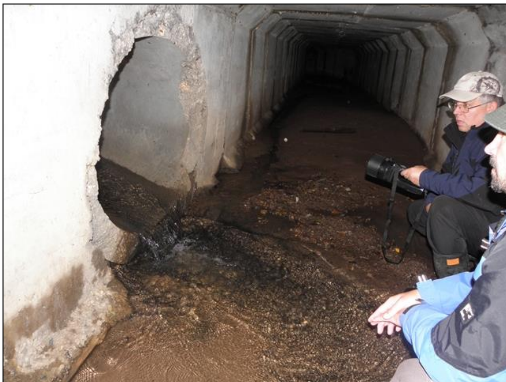
Stávající boční zaústění potoka rourou DN 1000 mm
