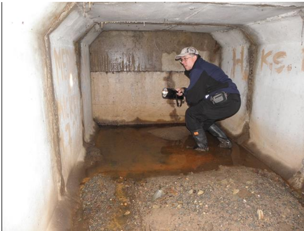
Zaslepené čelo stávajícího zakrytého úseku
