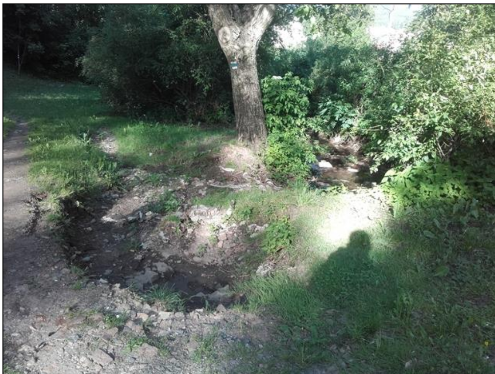
Levobřežní nátrž pod nekapacitním propustkem
